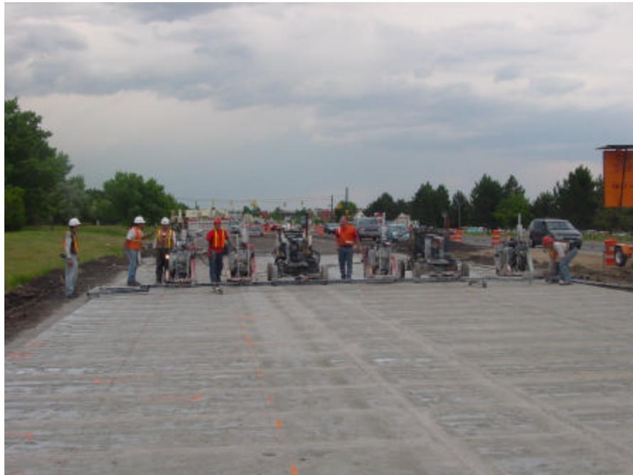
**Figure 37. Sawing Longitudinal Control Joints**
